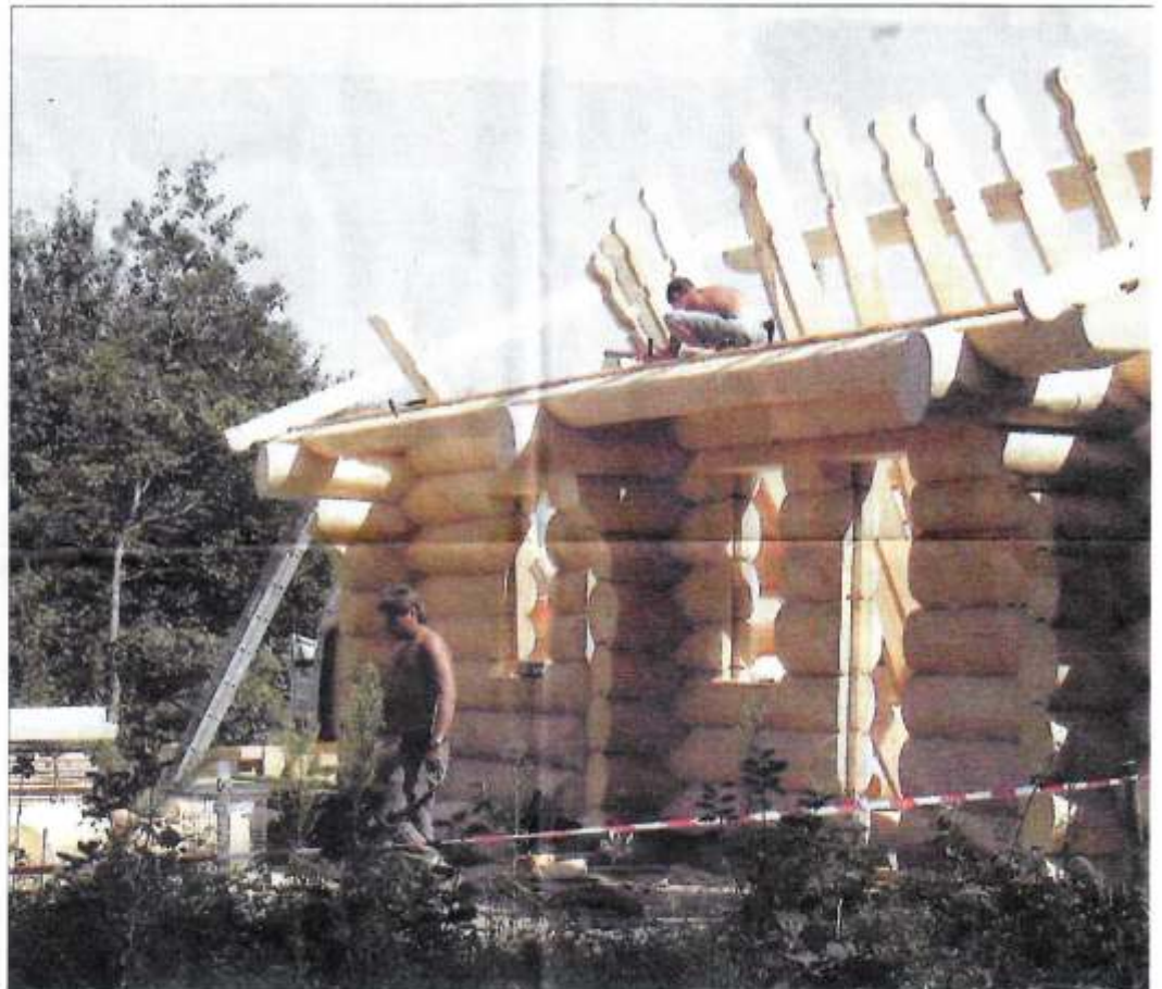
Seit Mittwoch sind die Arbeiter im Wald zugange, heute soll der „Rohbau“ der neuen Hütte stehen. Und wer kennt, macht das Blockhaus optisch einiges her.
