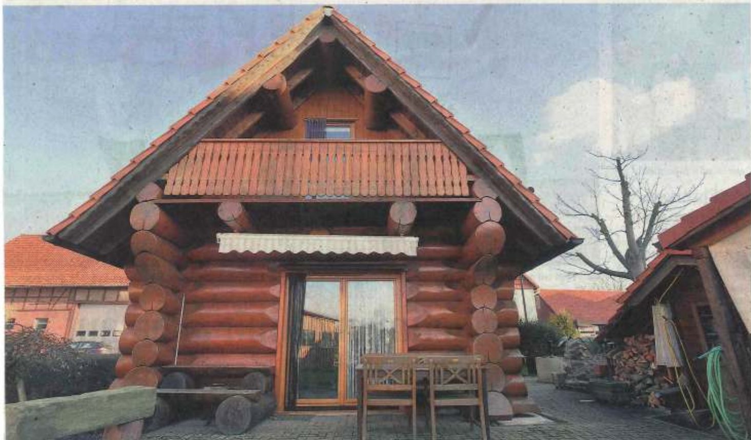
Spezielles aus Holz: Block-Stamm-Haus in Seeburg versprüht auch nach 20 Jahren noch seinen rustikalen Charme.
